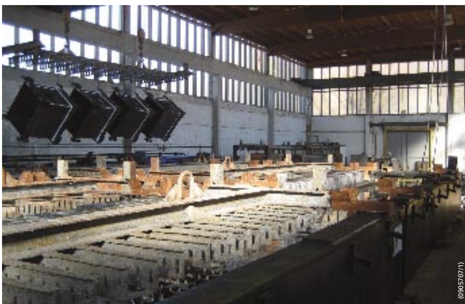
Seit 2007 hat die Feuerverzinkerei Walter Birlenbach 1,7 Mill. € in neue Anlagen investiert – u. a. in eine komplett neue Vorbehandlung (Foto: Feuerverzinkerei Walter Birlenbach).
